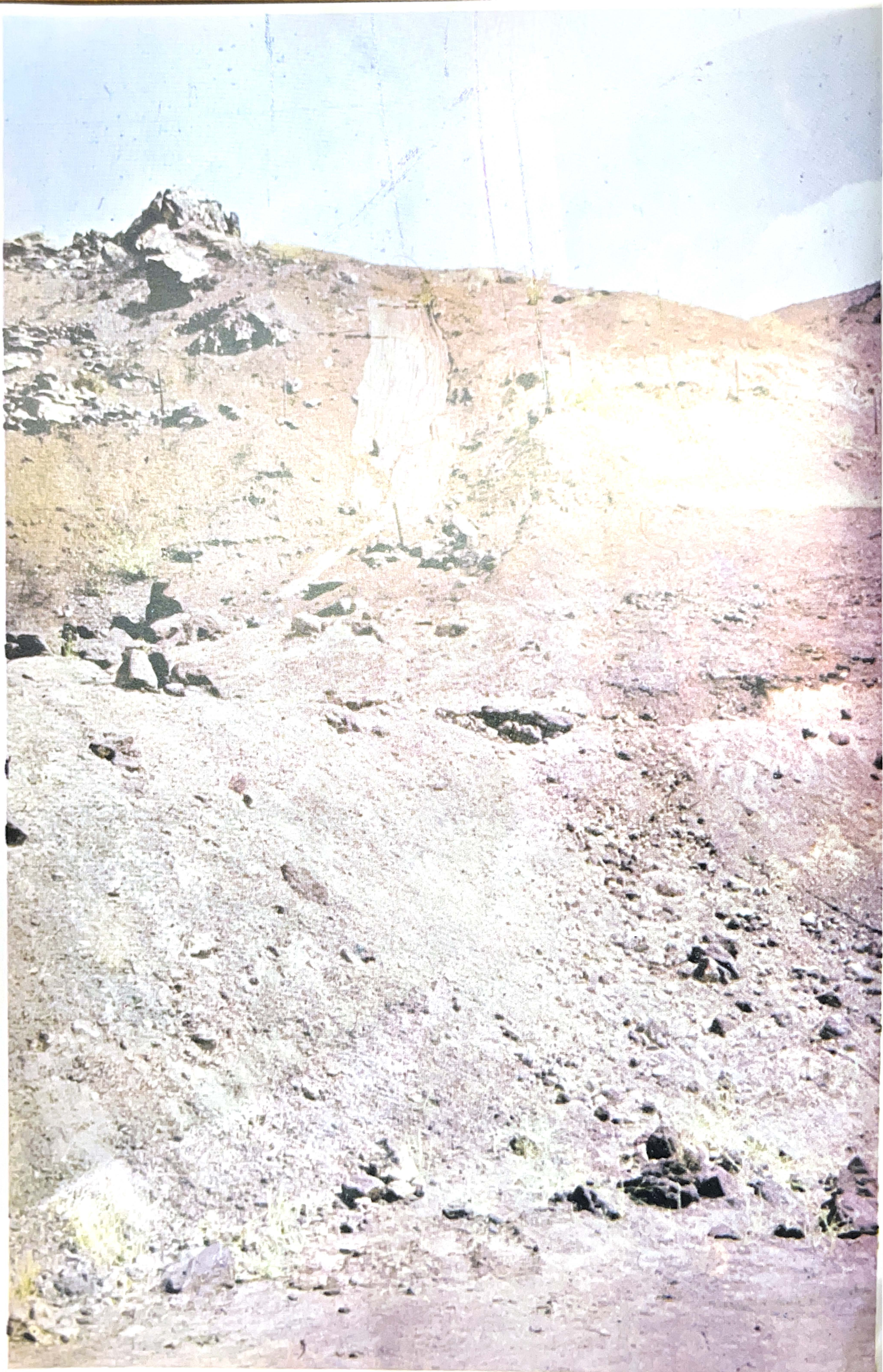
تصویر ۴ - برای جلوگیری از فرسایش و خطرات ناشی از آن زهکش های سطحی و آبروها در نقاطی چند با چتائی قیر اندود پوشیده شده است .
